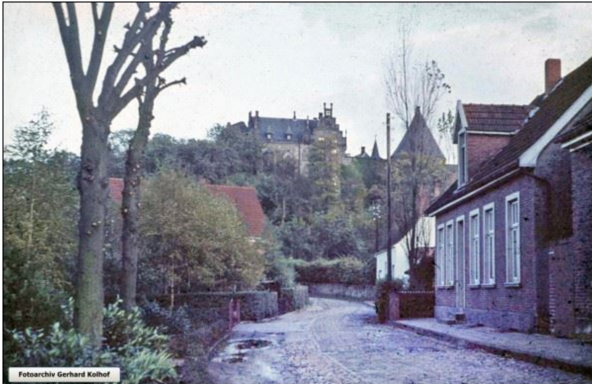
Die gepflasterte Hofstiege, 1970, Blick auf die Westseite des Schlosses.
