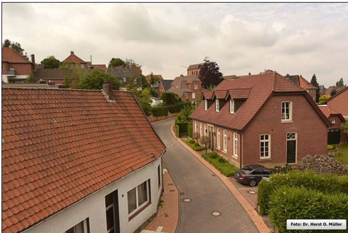
Hofstiege, weiterer Verlauf nach Südwesten
