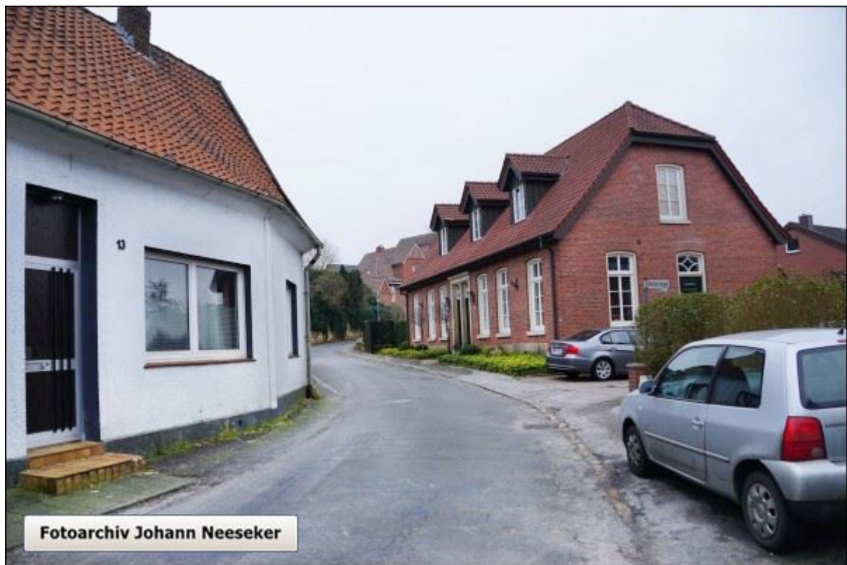
Die Hofstiege nach Südwesten
