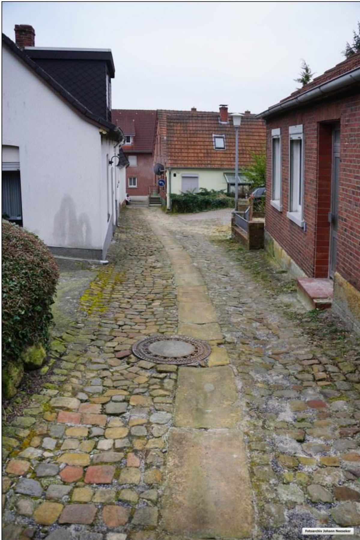
Mauerstiege, hügelabwärts, zur Wilhelmstraße, nach Süden.
