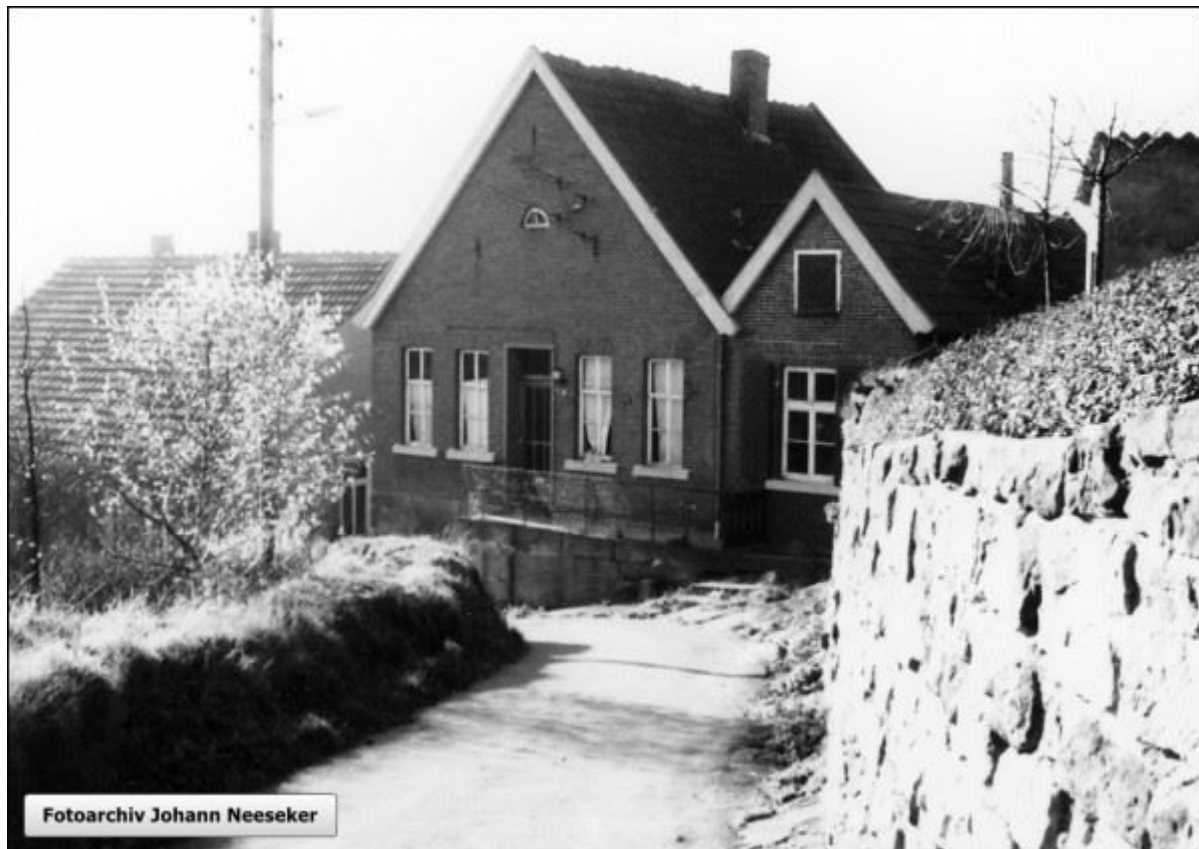
Obere Mauerstiege, Blickrichtung Südwesten.
