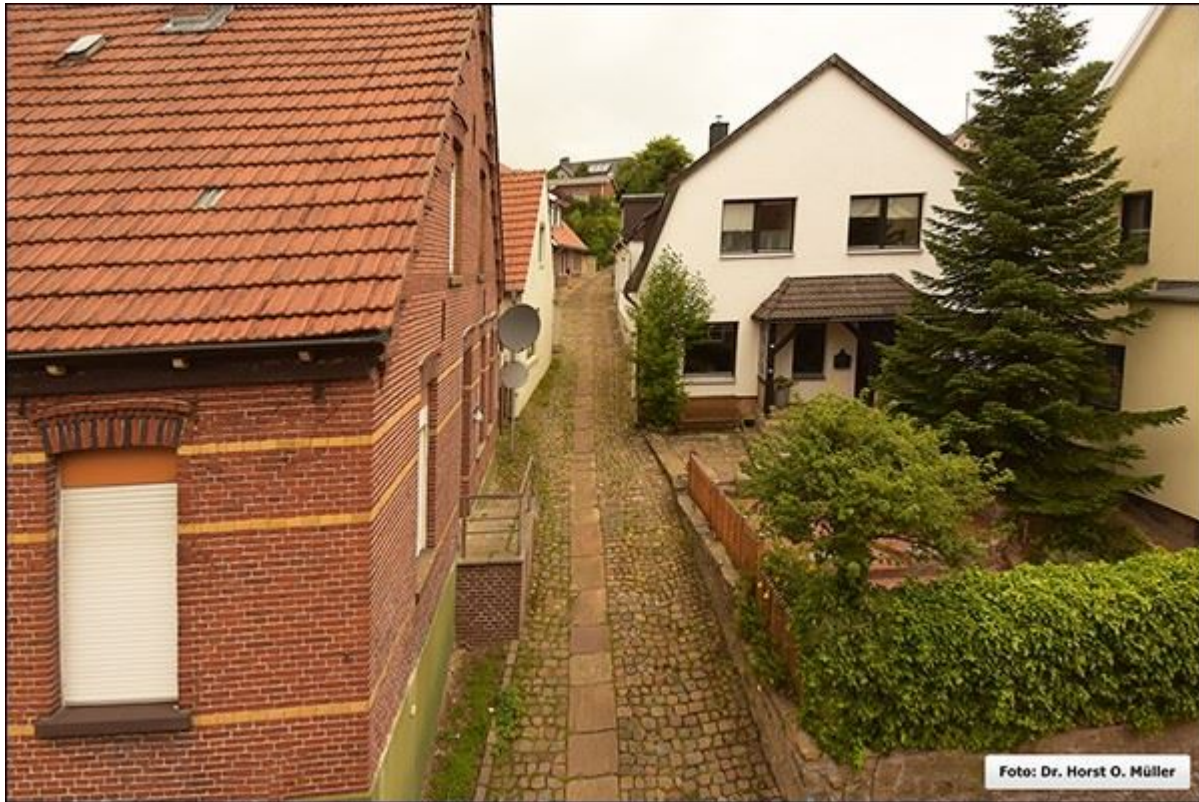
Blick die Mauerstiege hinauf nach Norden 2020
