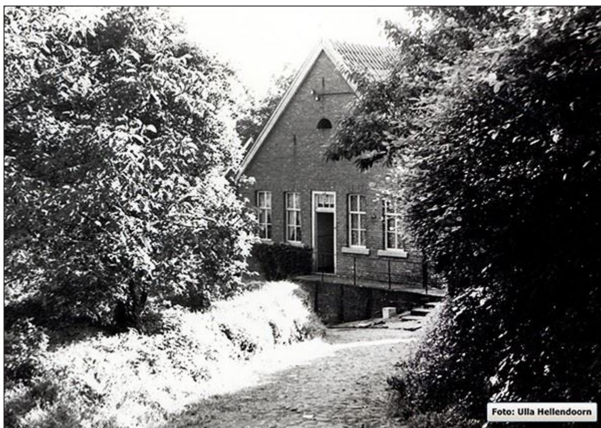
Obere Mauerstiege, Blickrichtung Südwesten.
