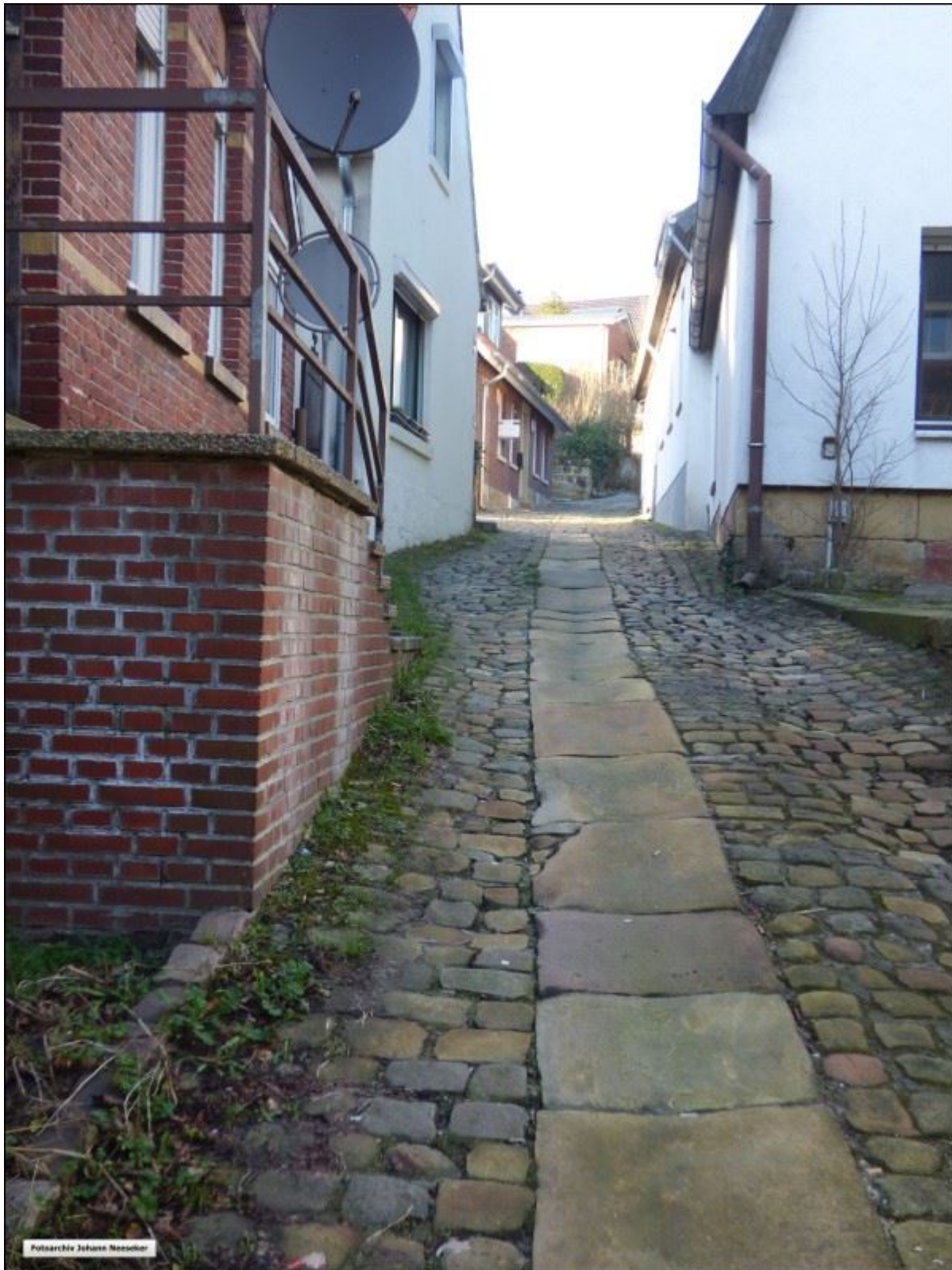
Untere Mauerstiege, nach Norden.
