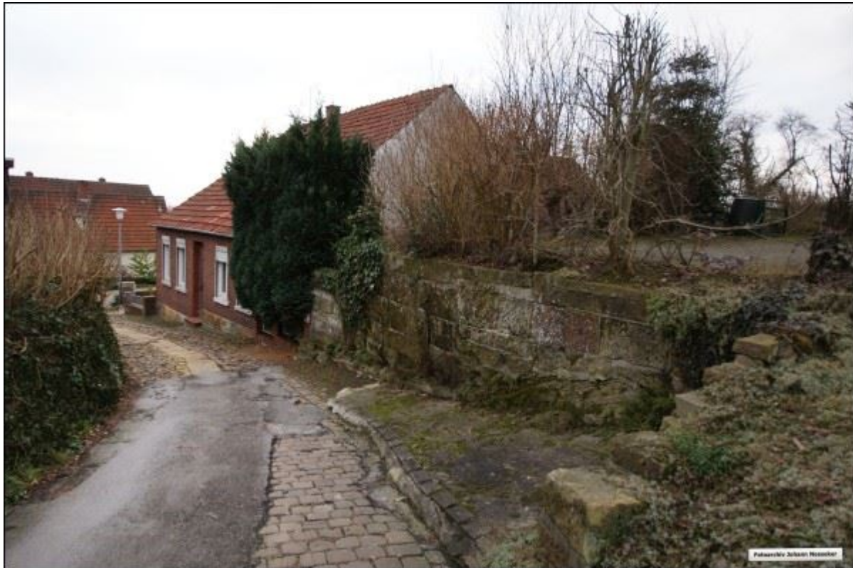
Blick zurück auf die untere Mauerstiege, nach Südwesten..
