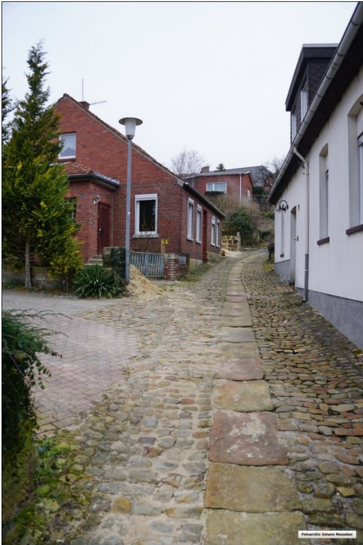
Untere Mauerstiege, nach Norden.
